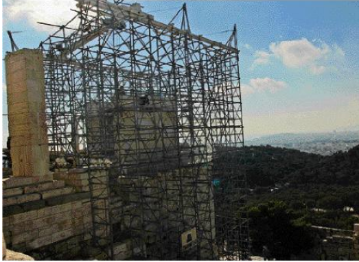
2008 → Η αναστήλωση του οικοδομήματος εξελίσσεται ικανοποιητικά πίσω από τα μεταλλικά ικριώματα
