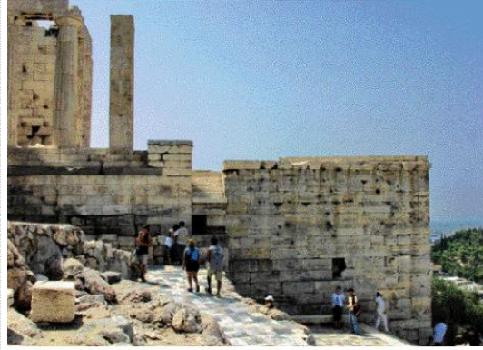
2000 → Η διάλυση του ναού έχει συντελεσθεί προκειμένου να αποκατασταθεί στην αρχική μορφή του
